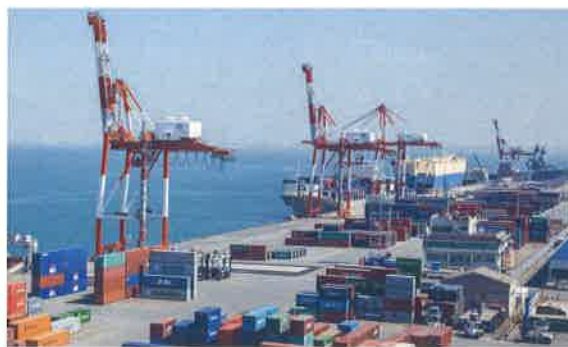
《ガントリークレーン》
